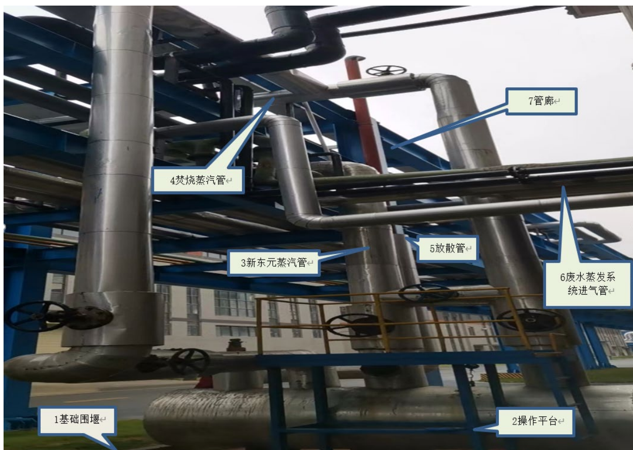
图1废水车间分汽缸现场图
