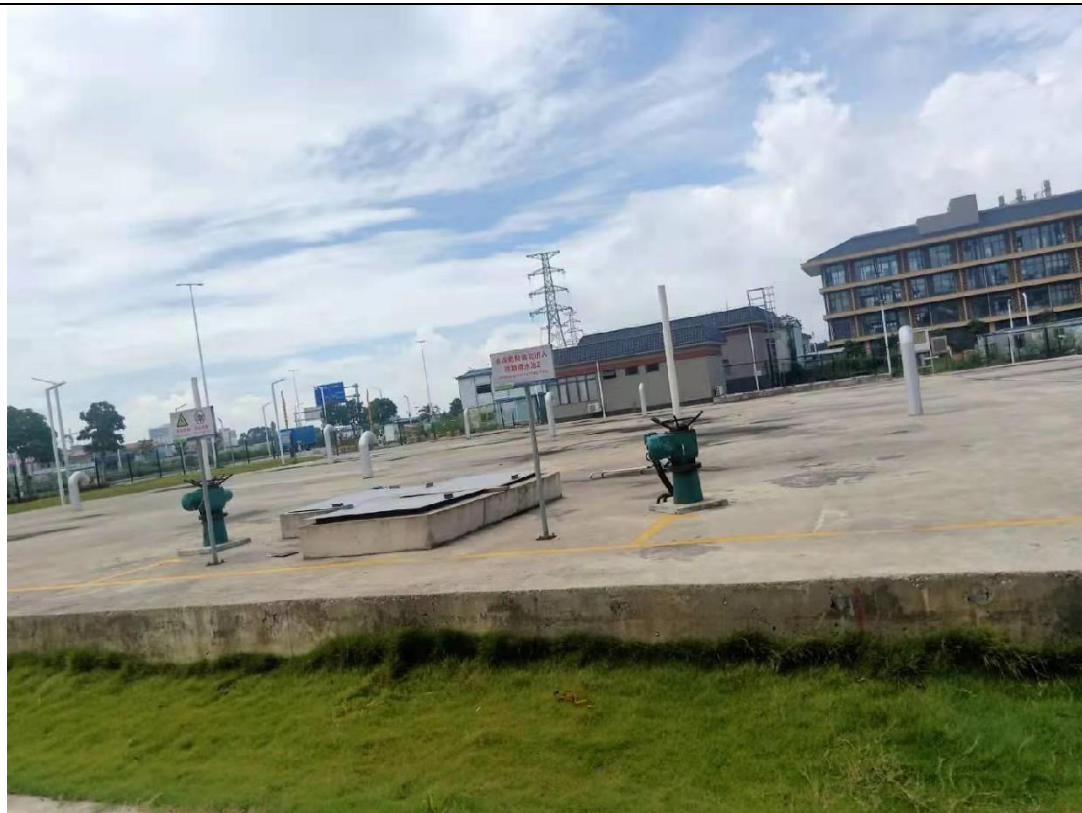
初期雨水池 2 和事故池
